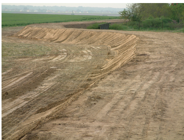
Lokalizációs töltések építése a kritikus szakaszokon
